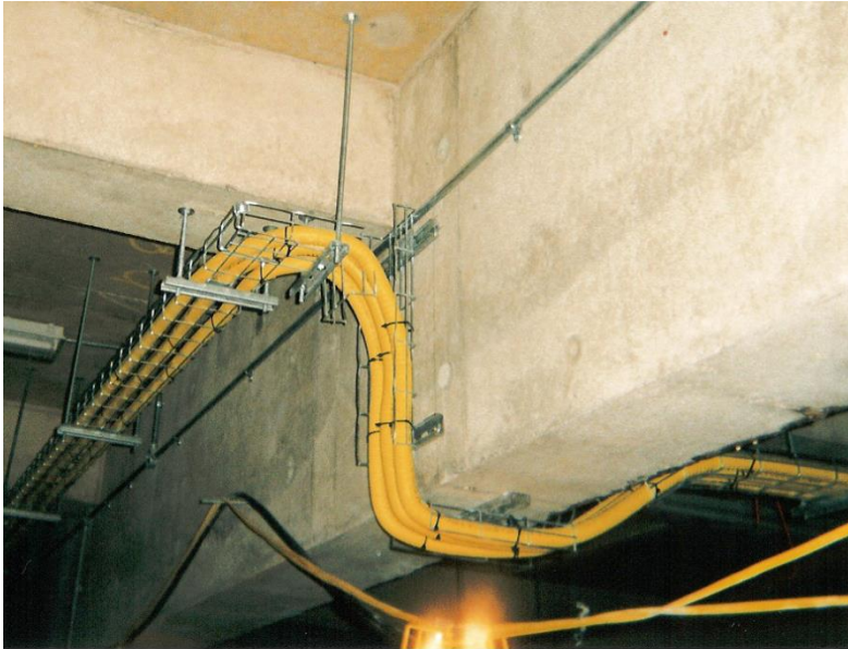
TracPipe® buizen in een bundel zonder onderlinge tussenafstand
